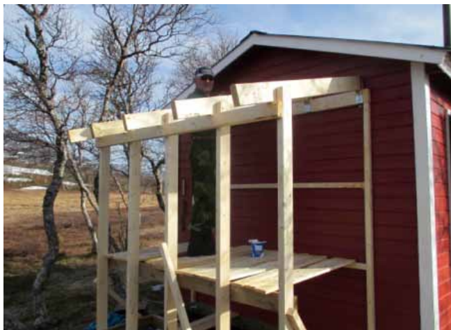
När takstolarna var på plats gjorde vi kväll och åt en välförtjänt middag.
