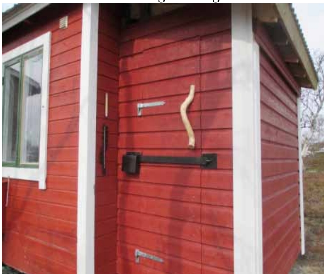
Under fredag förmiddag var det lite justeringar och kompletteringar med dörrhandtag och kompletteringsmålning. Dörrhandtaget tog lite tid men vi lyckades rät bra om vi får säga det själva. Vi kompletteringsmålade spikhuvuden och mm samt att dasset fick lite färg.
