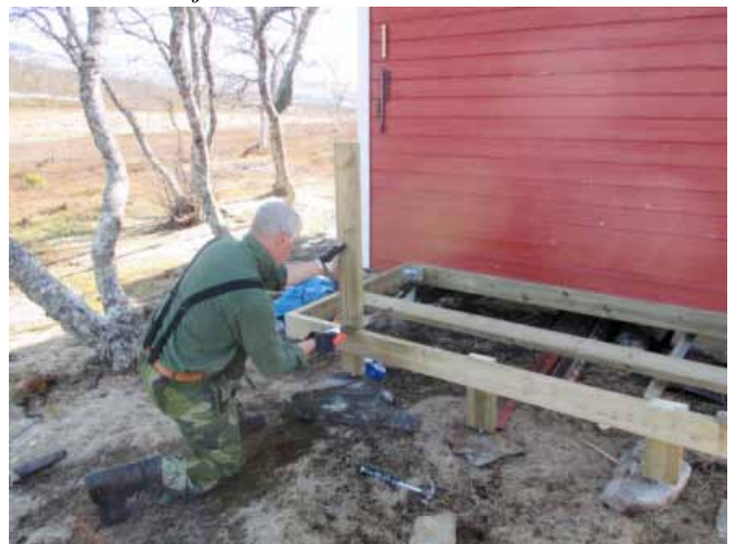
Efter en sen lunch påbörjade vi bygget med att leta grundstenar. Vi fann några lämpliga och bjälklaget blev stabilt.
