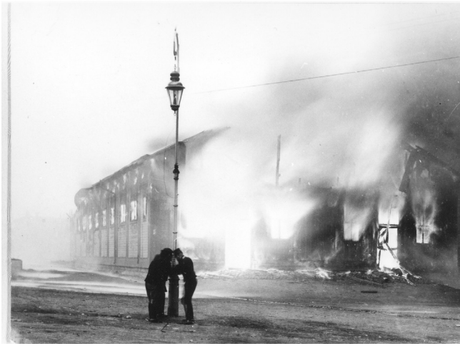
1914 inträffar en dramatisk brand i stallet intill ridhuset. Stallet i trä brinner ned fullständigt, men stenbyggnaden ridhuset klarar sig.
